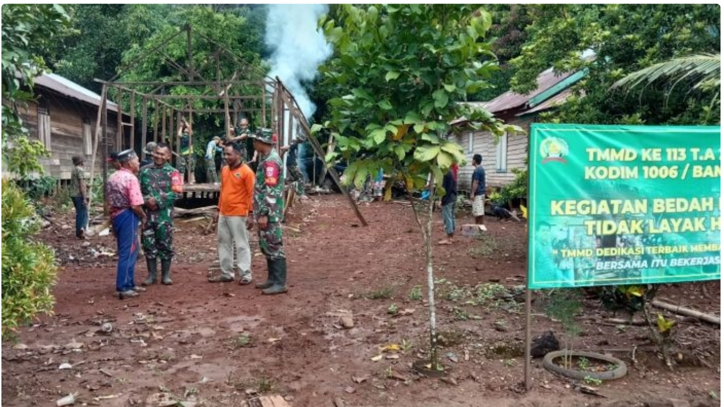
Satgas TMMMD ke-113 Kodim 1006/Banjar Mulai Kerjakan Rehab Rumah
