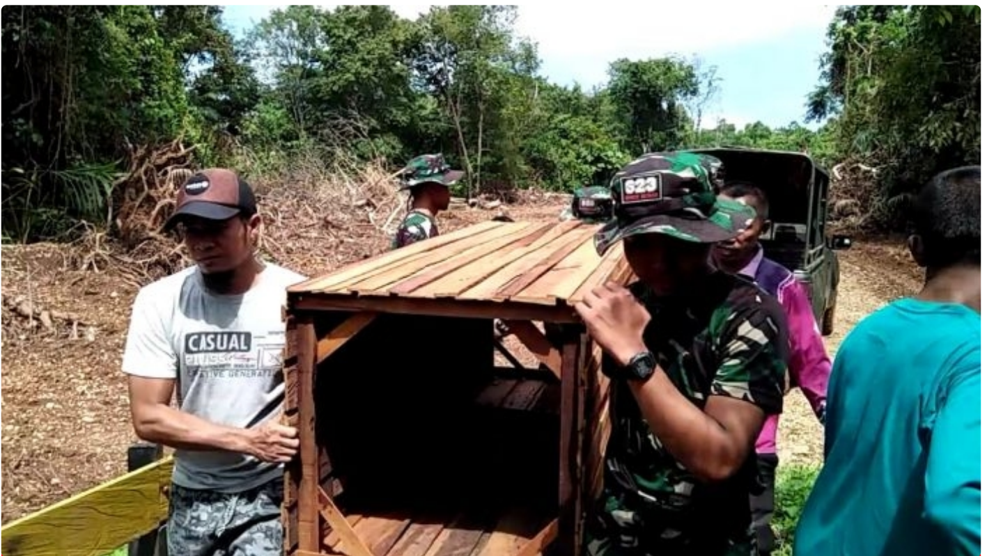
Anggota Satgas TMMD Angkut Material Untuk WC
