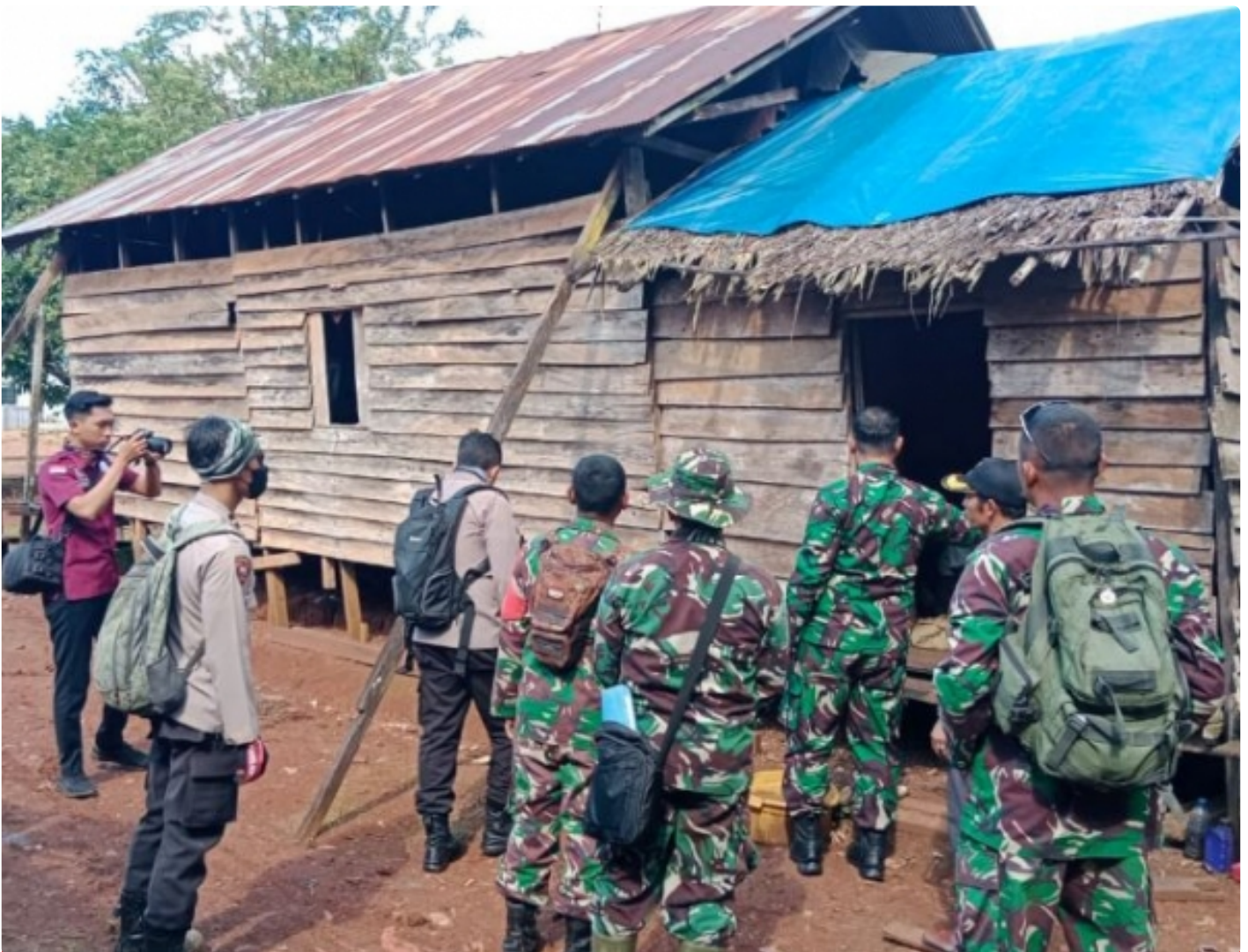
Kondisi Awal Rumah Nenek Marawiyah (Sasaran Bedah Rumah) Sargas TMMD ke-113 Kodim 1006/Banjar
