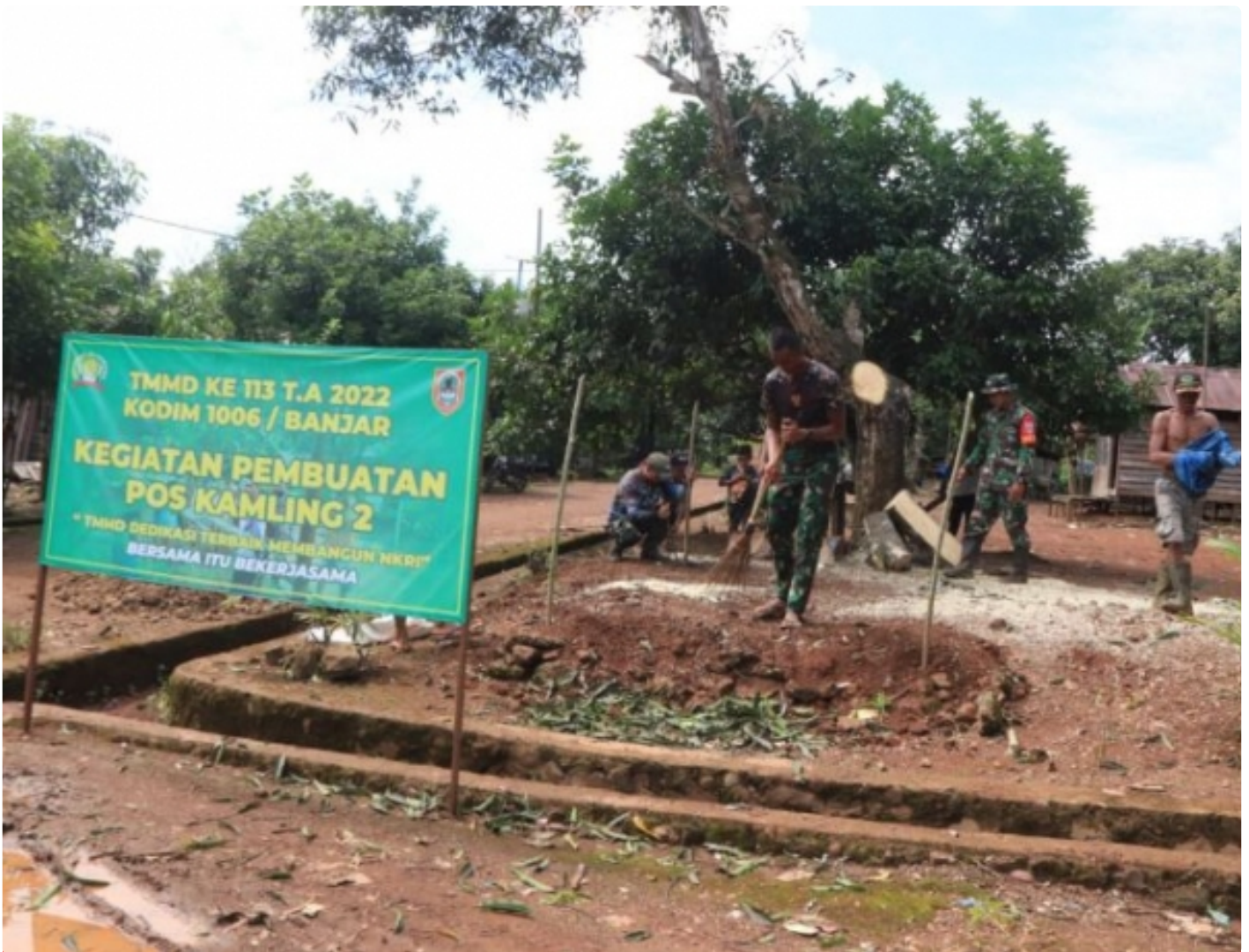
Lokasi Pembuatan Pos Kamling TMMD ke-123 Kodim 1006/Banjar
